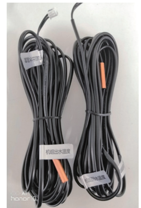
机组出水 / 回水温度传感器
